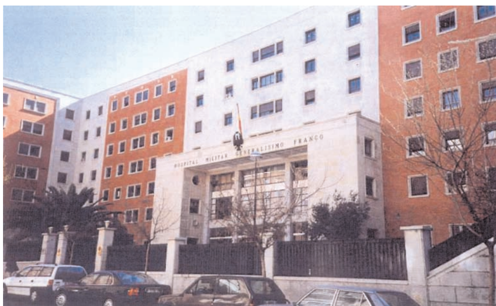
14. Hospital Militar del Generalísimo de Madrid, 1964 (Inspección General de Sanidad de la Defensa)
